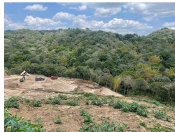
VISTA PARCIAL DE INMUEBLE
