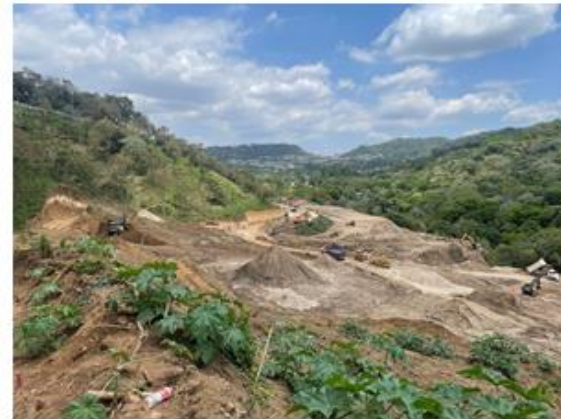
VISTA PARCIAL DE INMUEBLE
