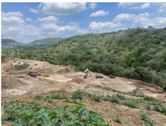
VISTA PARCIAL DE INMUEBLE
