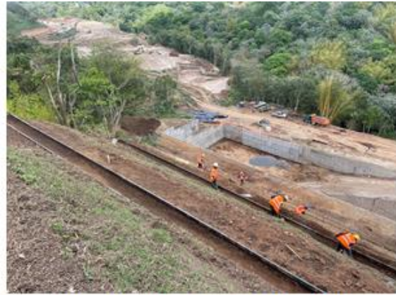
VISTA PARCIAL DE INMUEBLE
