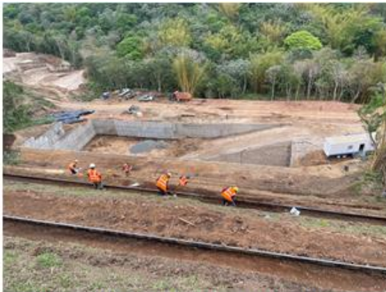
VISTA PARCIAL DE INMUEBLE
