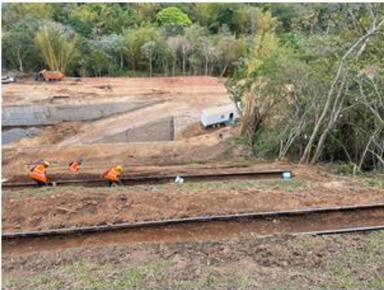
VISTA PARCIAL DE INMUEBLE
